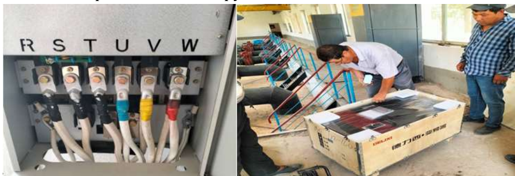
Рис. 1-2. Процесс установки преобразователя частоты для плавного пуска электродвигателя на насосной станции «Кунгир-2» Камашинского района
