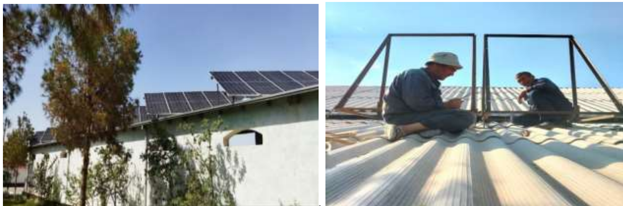
Рис. 3-4. Солнечная электростанция мощностью 30 кВт установлена для административного здания на территории «Управления насосных станций и энергетики при Аму-Кашкадарьинском бассейновом управление ирригационных систем»
